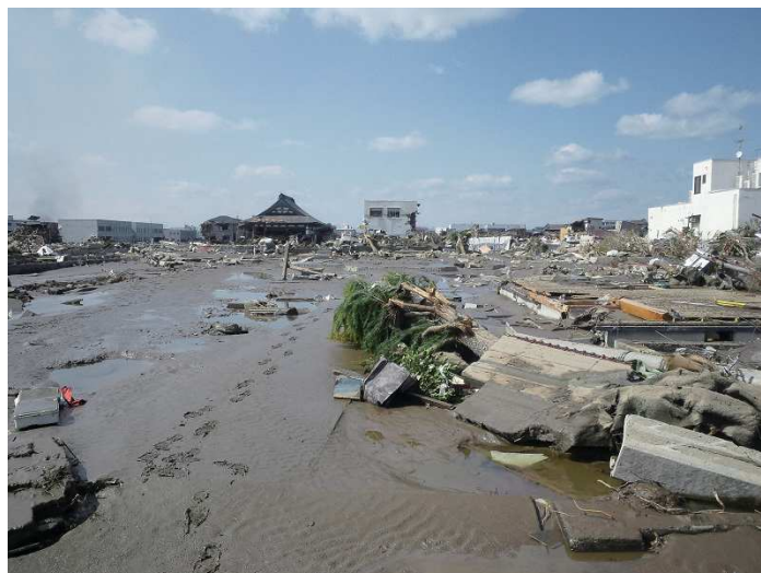
■震災後 鳥居跡から境内方向の写真: 閑上湊神社(宮城県名取市)
